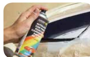
Lijar la superficie. Proteger el entorno y aplicar Motip Primer. Aplicar Motip Kompakt pintura. Rocíe dentro del área protegida.
